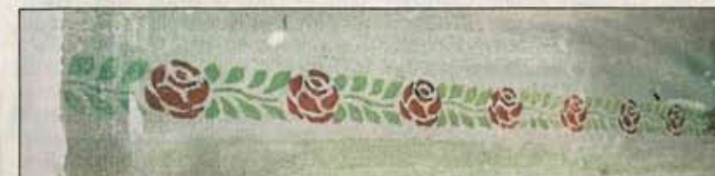
Während der grundlegenden Sanierung wurden einige Schätze gefunden, darunter eine Schablonenmalerei aus roten Rosen und grünen Blättern.
