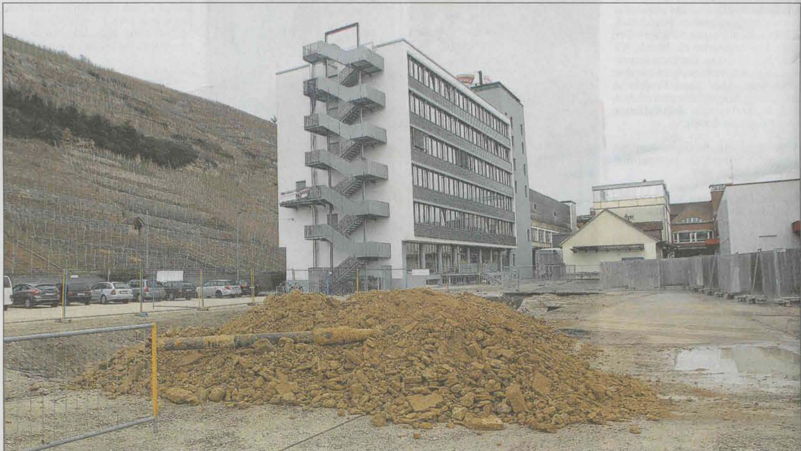
Vorbereitungen für den Baubeginn: Hinter der Volkshochschule entsteht am Roßneckar ein Wohnheim mit Tiefgarage.
